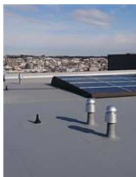
屋上防水工事
