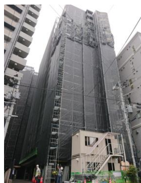
外壁タイル補修工事
