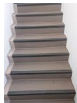
階段用床材新設工事
