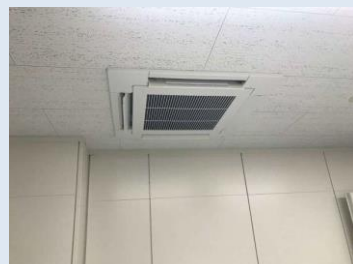
MRRデルタビル (エアコン交換)
