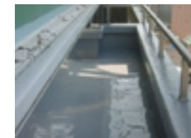
屋上防水工事
