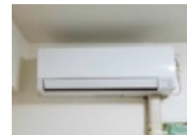
エアコン交換
