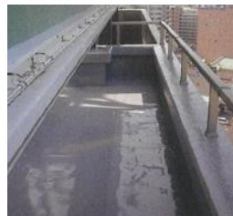
屋上防水工事
