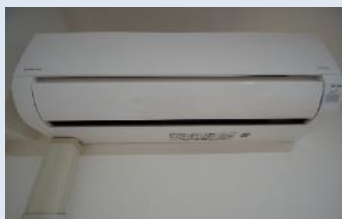
エアコン交換 (アルティザ博多駅南)
