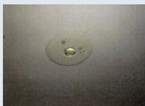
非常用照明LED工事 (MRRあきたⅡ)
