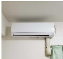
エアコン交換
