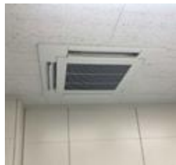
空調更新工事
