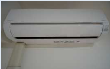
エアコン交換 (アルティザ博多駅南)
