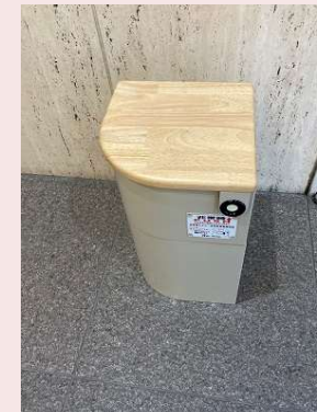
EV内 防災設備の設置 (池下ESビル)
