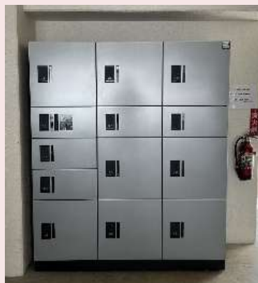
宅配BOX設置 (アルティザ東別院他)
