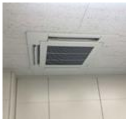
空調更新工事
