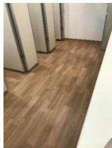
トイレ床材更新
