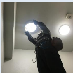
LED照明設置 (11物件導入済み)
