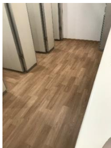
トイレ床材更新
