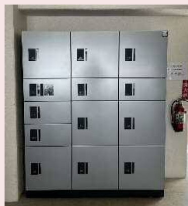
宅配BOX設置 (アルティザ東別院他)
