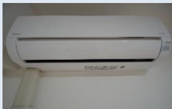
エアコン交換 (アルティザ博多駅南)
