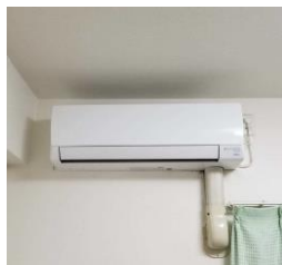
エアコン交換
