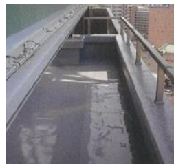
屋上防水工事
