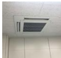
空調更新工事
