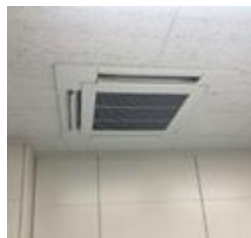
空調更新工事
