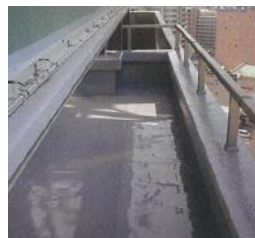
屋上防水工事
