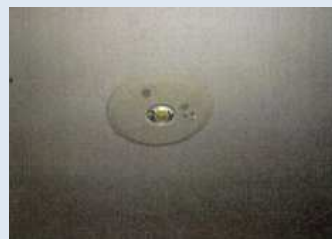
非常用照明LED工事 (MRRあきたⅡ)
