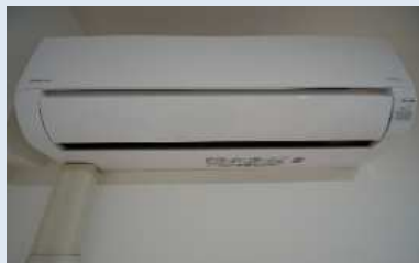
エアコン交換 (アルティザ博多駅南)
