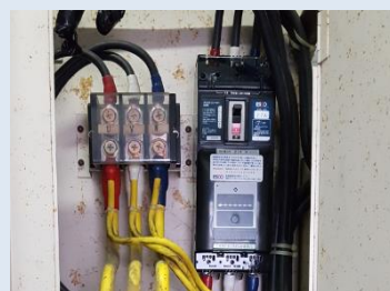
電子ブレーカー設置 (アルティザ上前津) (アルティザ相武台)
