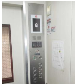
エレベーター改修工事
