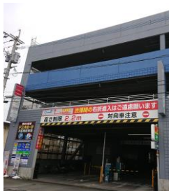
駐車場外壁塗装工事
