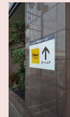
カーシェア設置 (アルティザ博多駅南)
