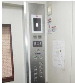
エレベーター改修工事
