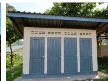
トイレ建設費
