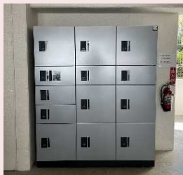
宅配BOX設置 (アルティザ東別院他)
