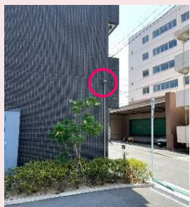
監視カメラ設置 (アルティザ淡路駅東他)
