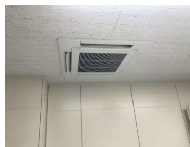
空調設備更新 (MRRデルタビル)
