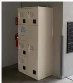
宅配BOX新規設置
