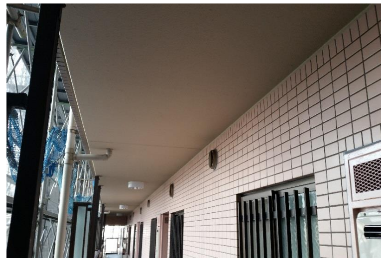
外廊下（廊下天井補修）
