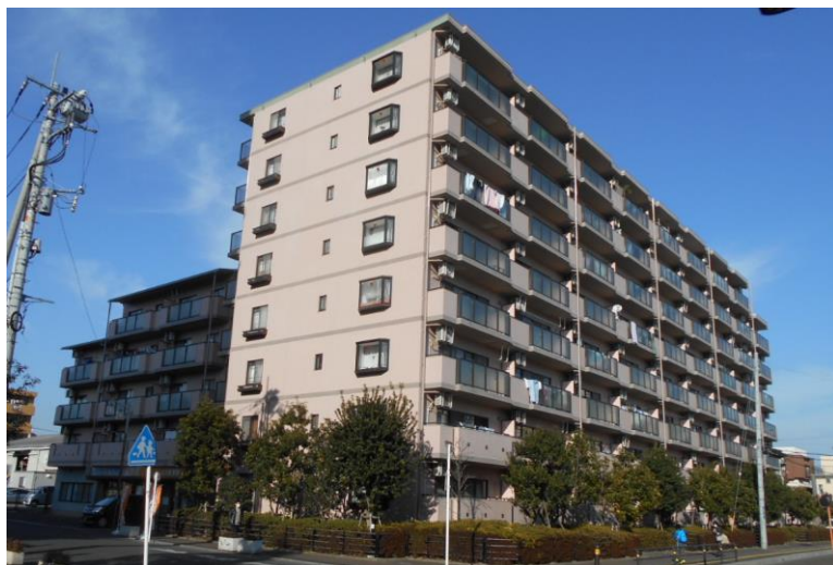
外観（タイル等補修）
