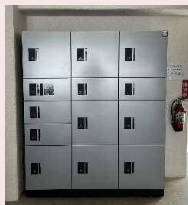
宅配BOX設置 (アルティザ東別院他)
