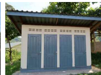
トイレ建設費
