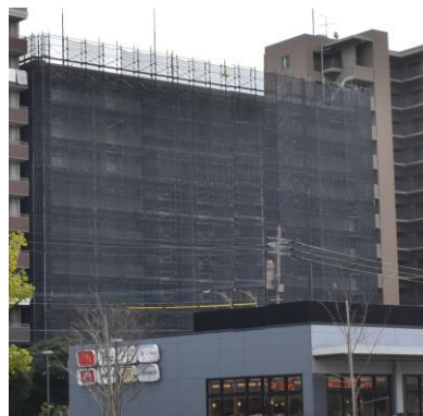
剥落防止剤塗布工事
