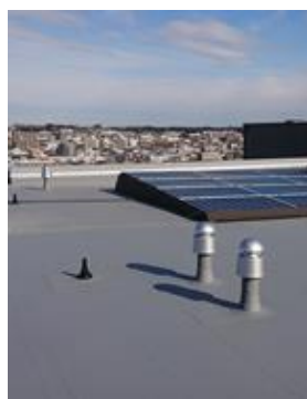
屋上防水工事
