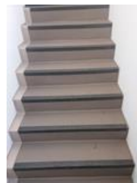
階段用床材新設工事
