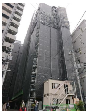
外壁タイル補修工事
