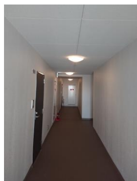
長尺シート更新工事
