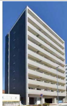
アルティザ東別院 所在地：愛知県名古屋市 竣工：2016年3月 戸数：54戸
