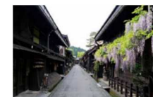
伝統的建造物群保存地区
