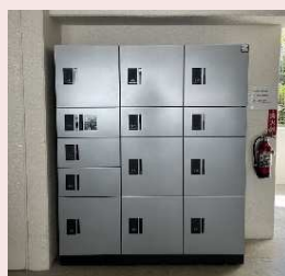
宅配BOX設置 (アルティザ東別院他)
